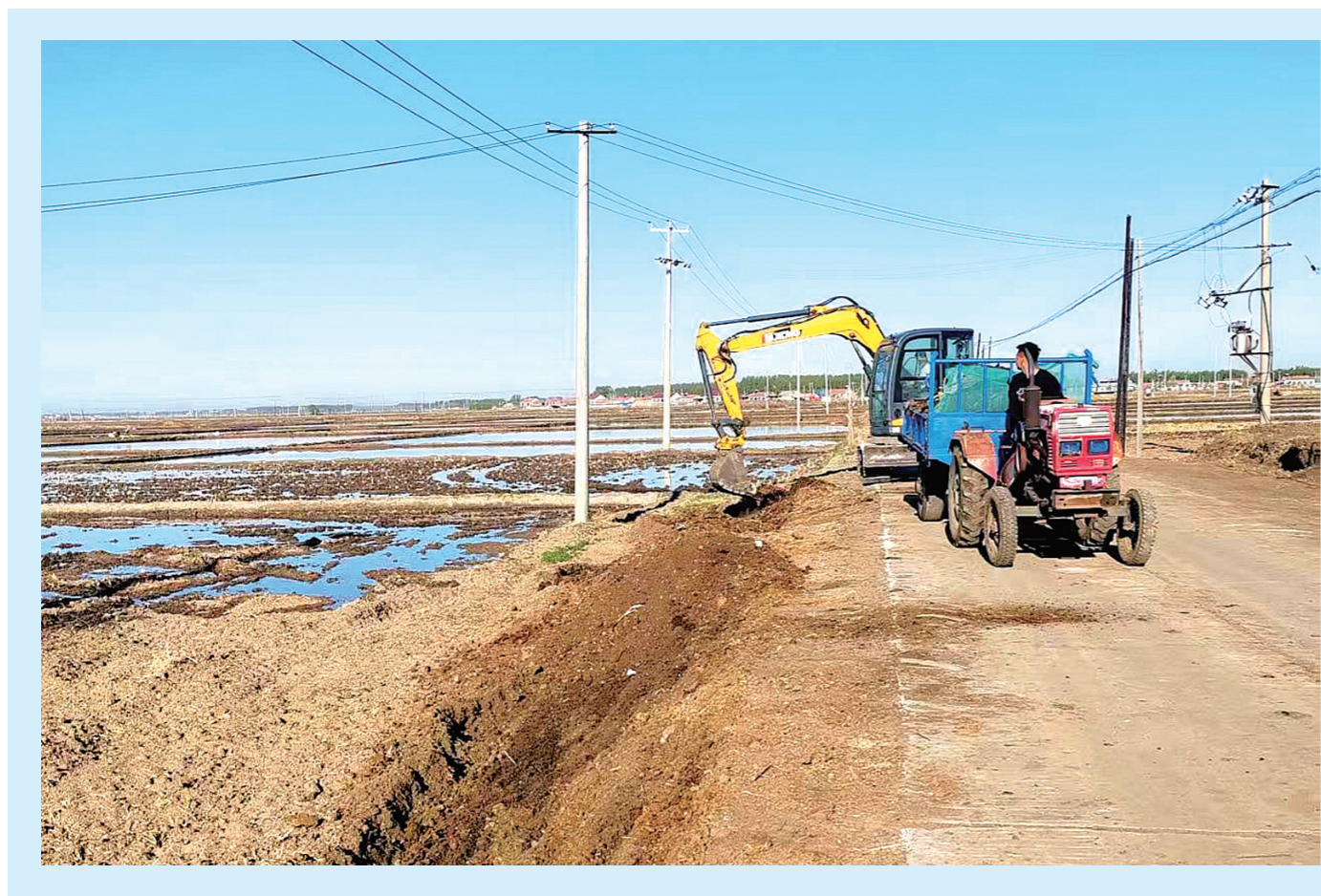
近日,双辽市新立乡公平村开展沟渠清淤及环境整治专项行动,采用机械与人工相结合的方式清理沟渠淤塞物、修整边坡,同步推进沟渠沿岸环境清理、生态修复及宣传引导,目前已完成主要干支沟渠清淤疏浚,有效提升沟渠行洪排涝和农田灌溉能力。 本报记者 白若楠 摄
