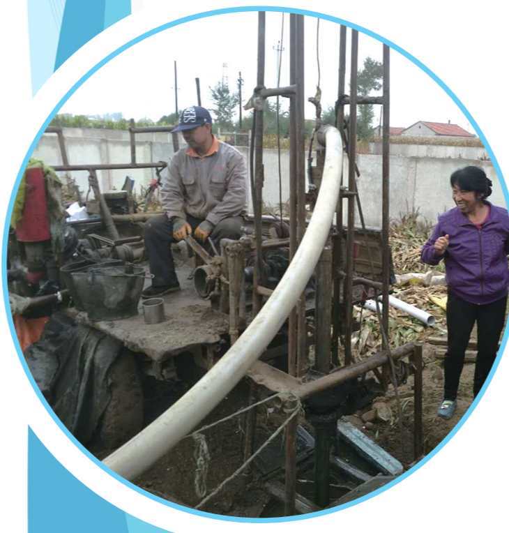
为帮扶对象打水井
