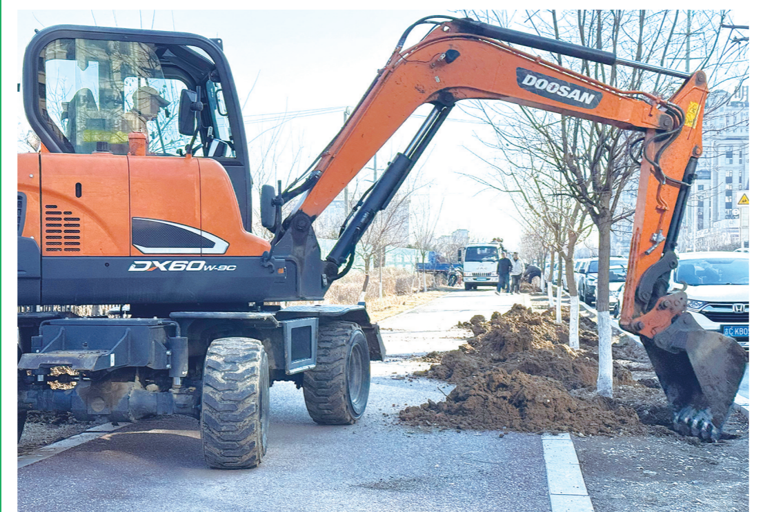
日前，铁西区园林部门启动春季绿化补植补栽工作，挖掘机开足马力作业，为城市添新绿、焕新颜，持续提升城市绿化品质。
