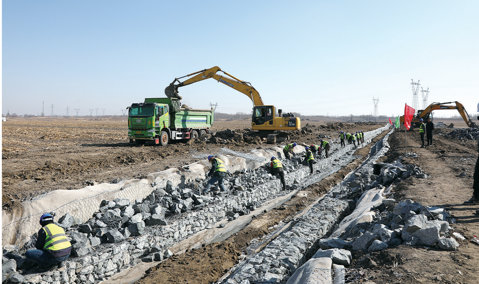
双辽市卧虎镇东方红村高标准农田建设项目为2025年新建项目,项目建设面积5500亩,总投资1389万元,目前已完成打井、有机肥抛洒、5条道路基层铺设及2.4公里预制矩形槽排水沟建设,正加快推进石笼排水沟施工,全力抢抓工期,确保春耕前完工。本报记者 张舰 摄
