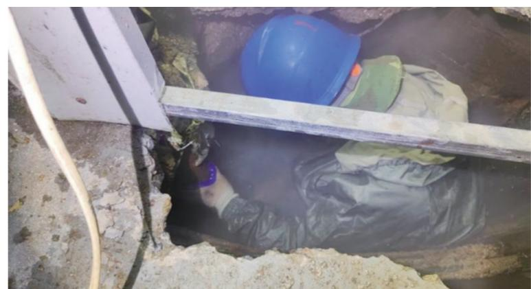
本报讯(通讯员 李明月)日前,四平热力大所辖区电大系统运行突发掉压故障,电大所第一时间启动应急响应,开展全方位、无死角的细致排查,最终精准锁定在9203号楼2单元供暖立杠因腐蚀严重而出现的漏点。若不及时处理,不仅会导致供暖质量下降,还可能引发更大的安全隐患。12月8日,电大所组织维修人员前往现场进行紧急处理。
