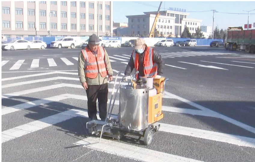
近日,双辽市交警大队联合双辽市住建局为主次干道道路施划标线,对磨损及模糊的车道分界线、斑马线、导向箭头等进行重新施划,有效明确车辆通行区域与行人安全通道,解决原有标线老化导致的辨识难题。 本报通讯员 李雪 摄
