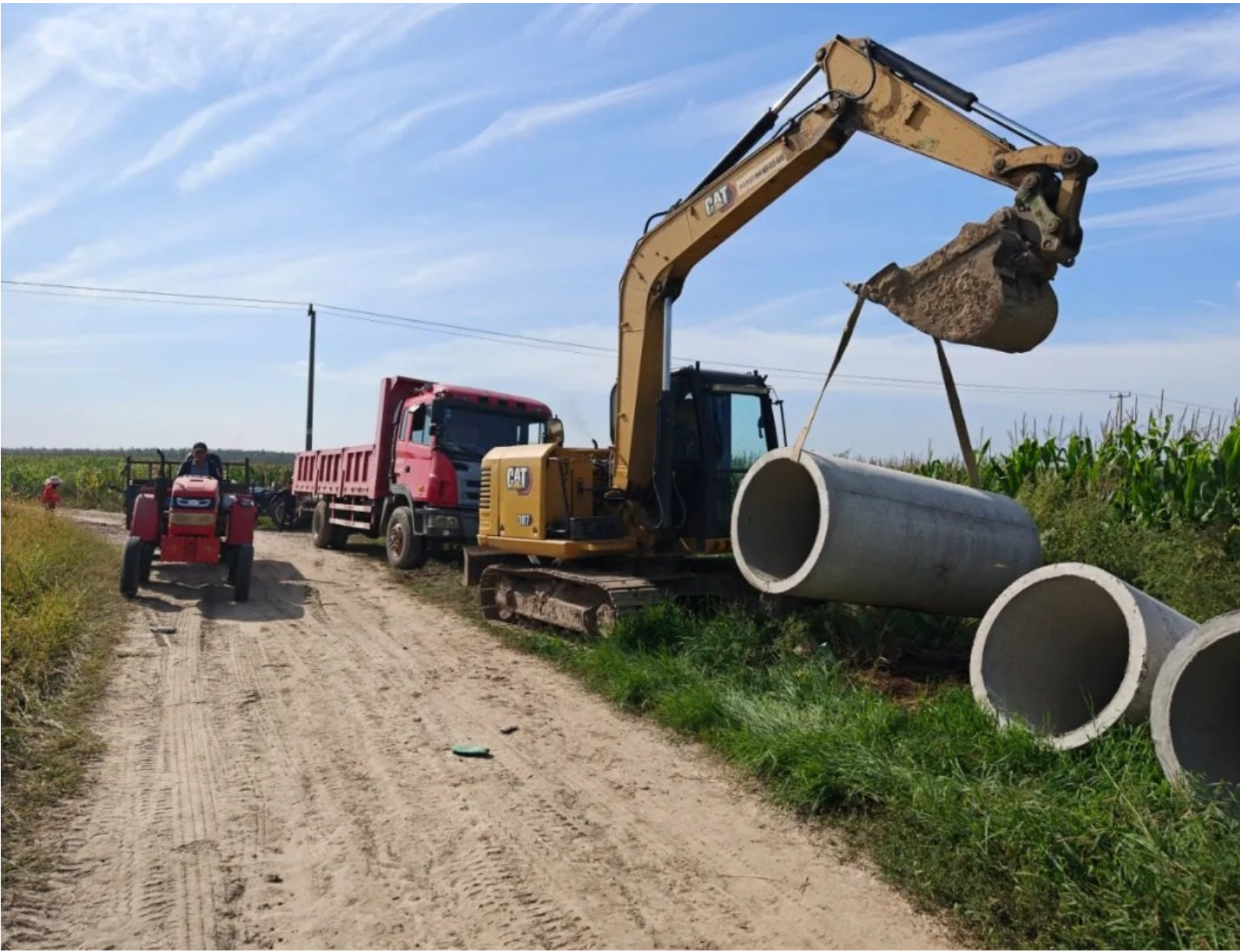
双辽市卧虎镇前六家子村党支部聚焦民生需求，完善基础设施，着力解决群众急难愁盼问题，通过铺设涵管、修整排水渠道，从根本上解决低洼地块排水不畅与交通不便问题。这是近日工人正在铺设涵管、修整排水渠道的场景。 本报通讯员 于嘉宇 摄
