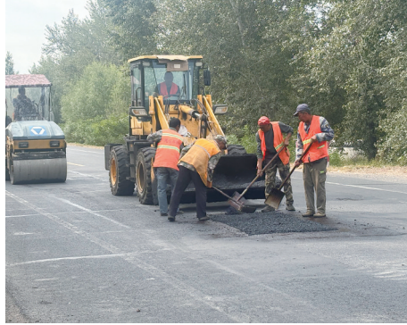
本报讯(通讯员 李轩澈)为保障国庆、中秋“双节”期间辖区交通运输秩序平稳、群众出行安全顺畅,国庆节前夕,市交通运输综合服务中心对管养的457.6公里干线公路展开拉网式排查。重点整治路基路面风险点,采取错峰施工方式,集中修补坑槽、清理边沟、修复交安设施,最大限度降低施工对通行的影响,为群众铺就平安舒心出行路。
