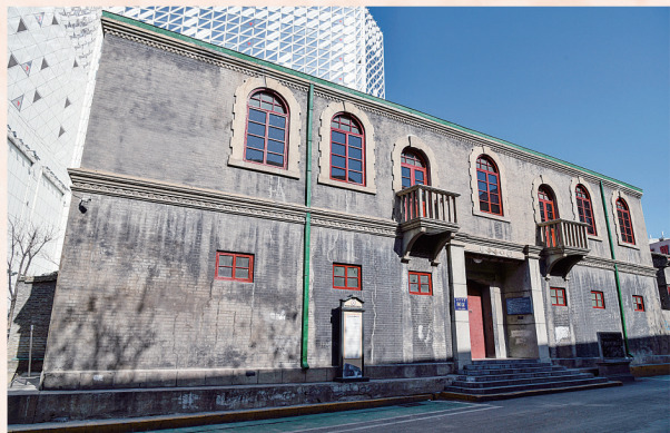
郑州东三马路80号，原日本驻郑领事馆旧址。
