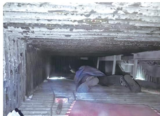
本报讯(通讯员 杨利娜 谢斌)7月8日，梨树热力作业现场，维修人员正在高温与局促空间的双重挑战下，对40吨锅炉的对流管束展开细致清理。
