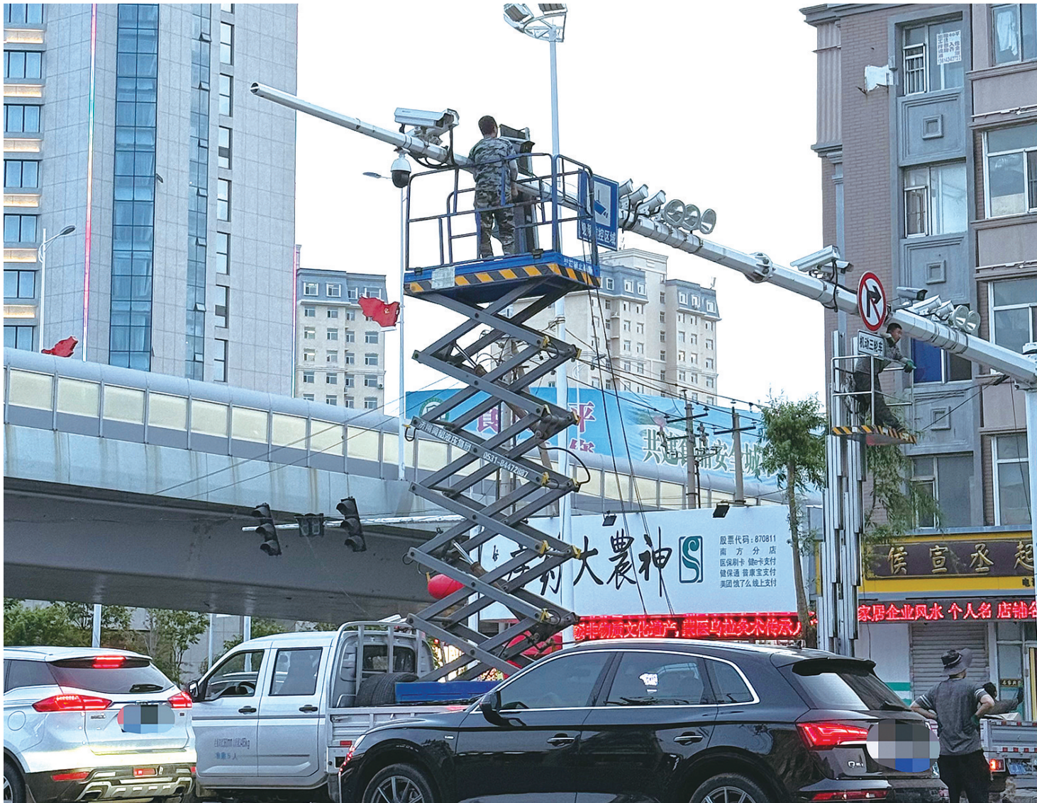
为保障交通设施正常运行、做好城市秩序的日常管理,近日,市政部门作业人员在铁西区南湖交通岗对交通监控设备进行检修维护,保障交通顺畅与安全。 全媒体记者 王明纯 摄
