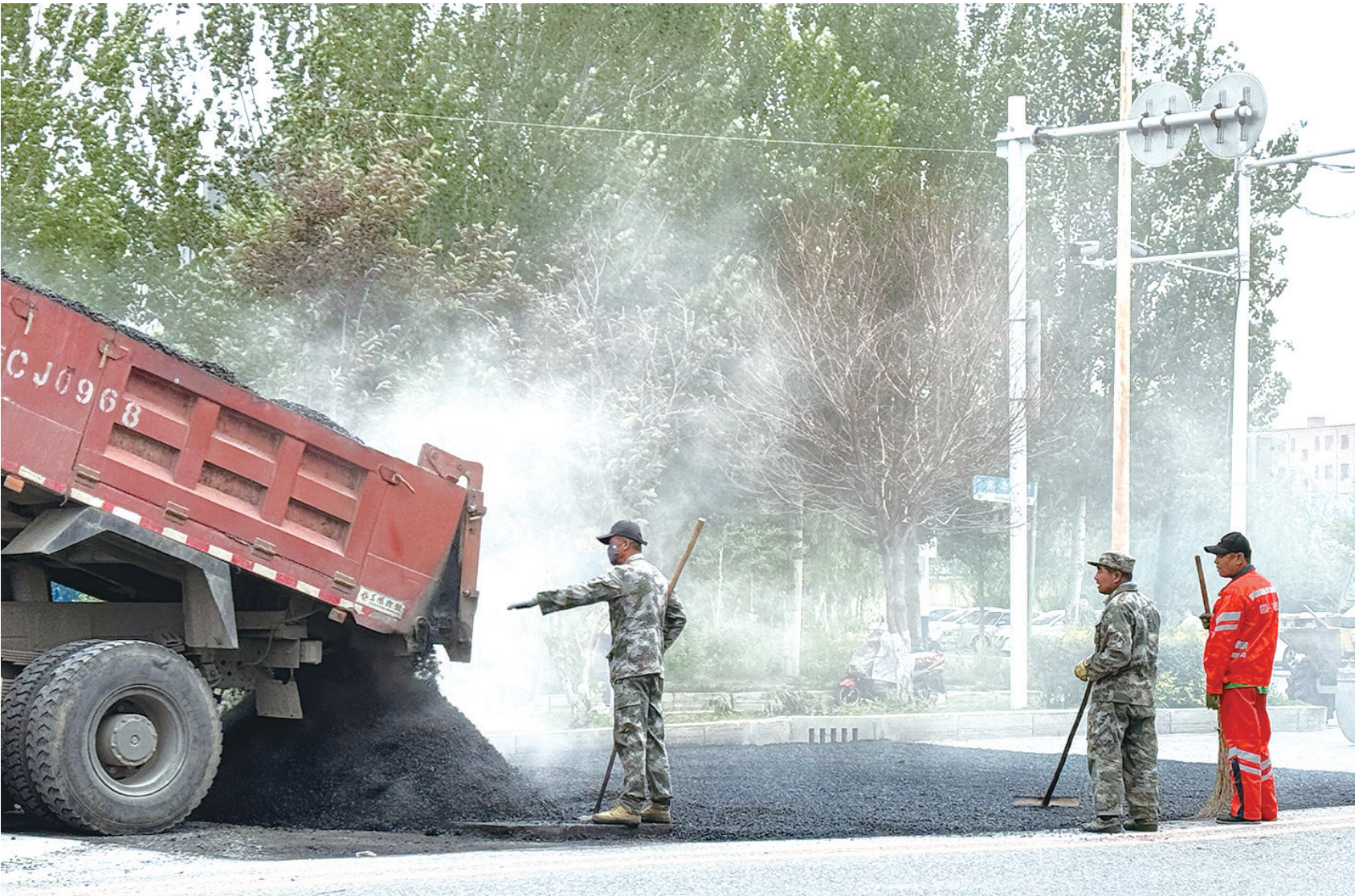
近日,我市政部门对铁西区东丰路的路面进行修补,维护道路交通安全,提高市政道路使用效率。
