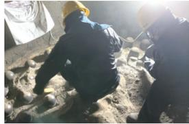
本报讯(通讯员 聂元元 田晓涛)随着夏季检修黄金期的到来,为确保今冬供暖季设备安全稳定运行,6月3日,四平热源厂启动四号锅炉炉膛风帽专项清理检修工程。通过精细化维护,消除设备隐患,为冬季供暖平稳运行筑牢基础。
