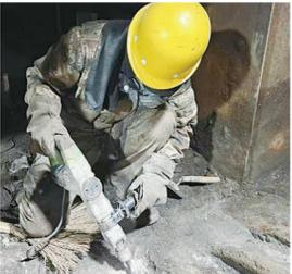
本报讯(通讯员 杨利娜 季鹏飞)百吨锅炉作为供热的核心设备,水冷壁如同它的“生命线”,对维持锅炉高效、安全运行起着至关重要的作用。长期在高温、高压环境下运作,部分水冷壁出现磨损、老化等状况。为排除安全隐患,5月27日,梨树热力利用夏季检修迅速组织维修力量,展开水冷壁局部更换工作。检修现场,维修人员手持工具,在狭窄且复杂的锅炉内部空间艰难作
