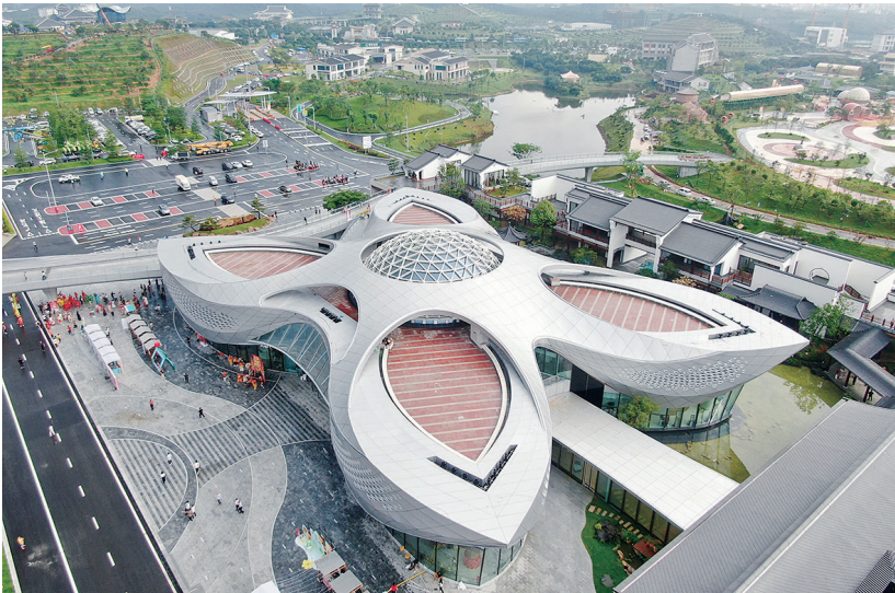
这是5月19日拍摄的包茂高速柏桥服务区。5月20日,广东首个以荔枝文化为主题的开放式特色服务区——包茂高速柏桥服务区正式投入运营。柏桥服务区位于“中国荔枝之乡”高州市根子镇与分界镇交界处,由保利长大承建,以“荔乡水韵,一枝独秀”为主题进行设计,整体造型就像一枝荔枝花。柏桥服务区在广东省内首创设置ETC车道与服务区外的道路相连,通过人行景观天桥串联起高速公路两侧景区、荔枝和村庄碧道。除实现交通服务设施的提质升级外,更成为集荔枝文化展示、特色农产品交易、乡村旅游集散、商业服务创新等于一体的综合服务区。
