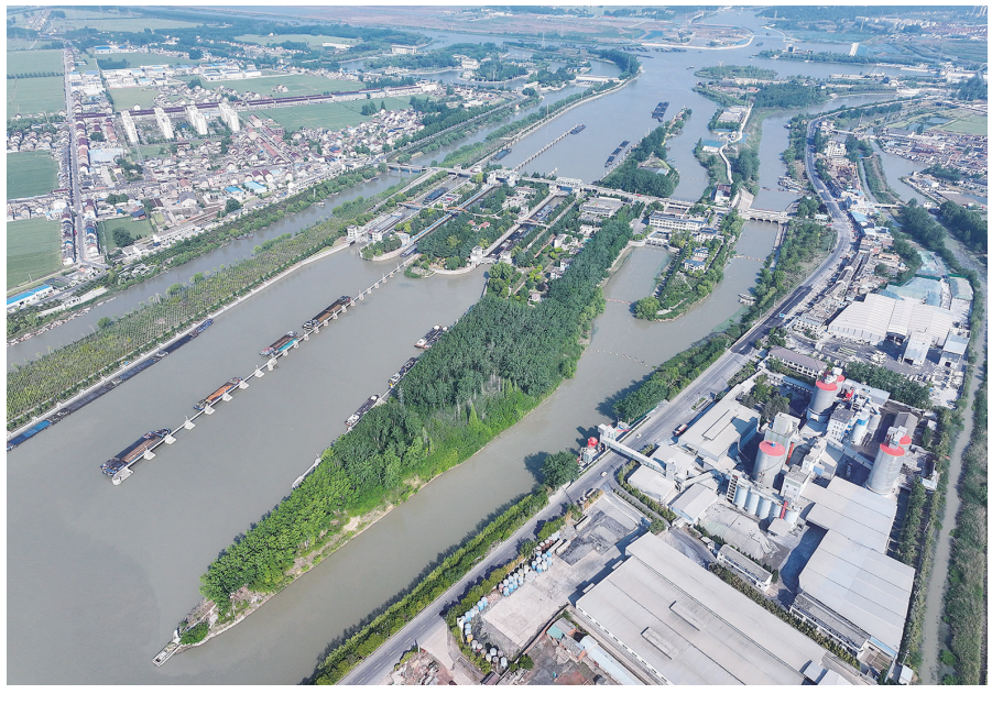
这是京杭大运河上的淮安船闸。近年来,江苏省淮安市围绕“文兴、水清、岸绿、业盛、人和”打造大运河百里画廊,绵延125公里,覆盖全城,聚力打造“古今辉映的运河人文画廊、蓝绿交织的运河生态画廊、转型升级的运河富民画廊、美好幸福的运河宜居画廊”。 李春鹏 摄
