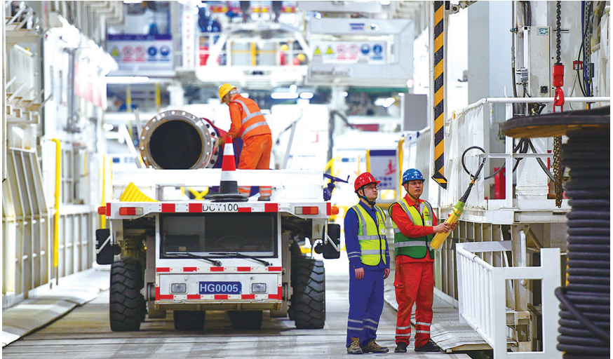
3月4日，中铁十四局建设者在济南市黄岗路穿黄隧道内施工作业。当日，山东省济南市黄岗路穿黄隧道进入黄河水域段施工，隧道盾构段已累计掘进1658米，开挖过半。济南市黄岗路穿黄隧道全长约5755米，其中盾构段长约3290米，盾构机开挖直径17.5米，是目前在建的世界最大直径水下盾构隧道。 朱峥 摄
