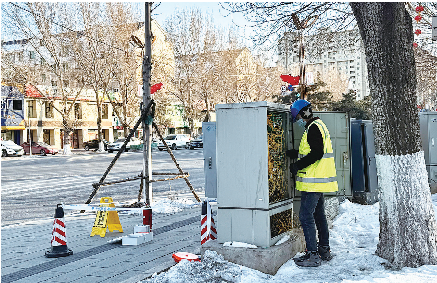
为确保通信网络的稳定运行,2月19日,市通信技术人员对铁西区南迎宾街道辅路上的光缆进行检修,保障广大市民正常使用网络服务,提供稳定、可靠的通信环境。
