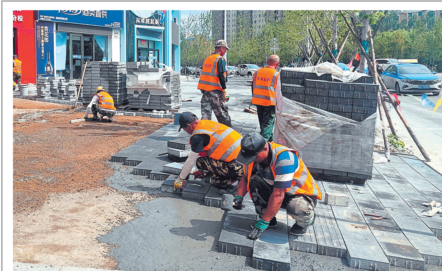
日前,我市住建部门组织施工人员对市内部分人行道砖体老化、破损、松动路段进行修复。图为施工人员正在铺设人行道方砖。 全媒体记者 孙莹 摄
