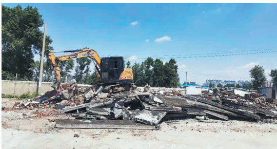
坚决制止违法占地，强制拆除违法构筑物。
