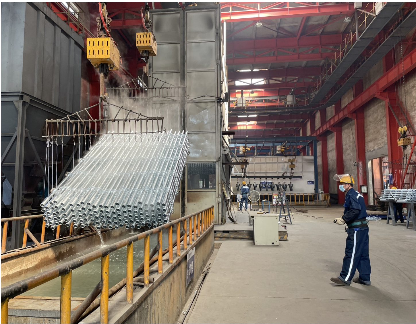
作为我市重点扶持企业,吉林金恒建材科技有限公司生产的主导产品在我国重型支撑领域占据一席之地,为高速公路、高速铁路、水利电力、港航项目建设提供助力,为我市制造业赢得声誉。 全媒体记者 张宪双 摄
