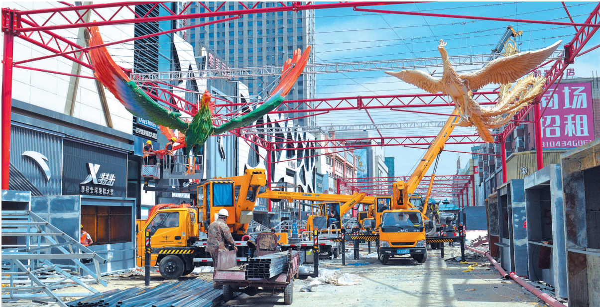
近日，四平“仁兴里”文旅街区空中结构建设正在如火如荼进行中。
