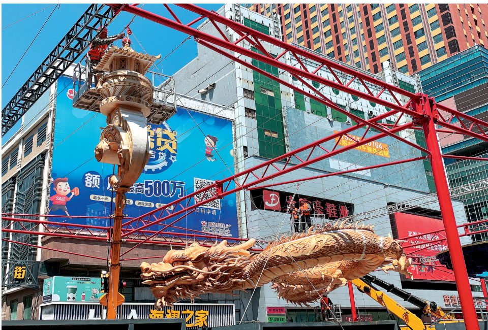
近日,“仁兴里”文旅街区空中结构搭建完成后,工人正在进行装置及装饰的悬挂固定。
