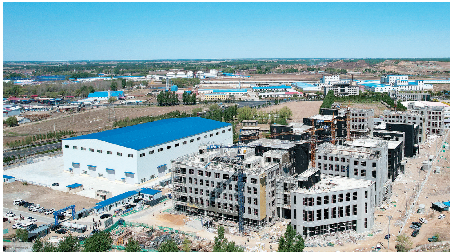
双辽医疗器械产业园项目总建筑面积32258.71平方米，园区打造研、产、办一体化，为引进医疗器械企业创新、创业提供软硬件基础设施条件。
