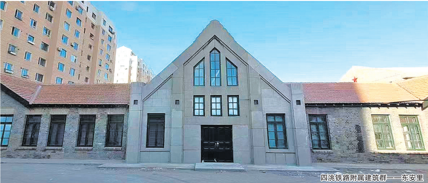
四洮铁路附属建筑群——东安里
