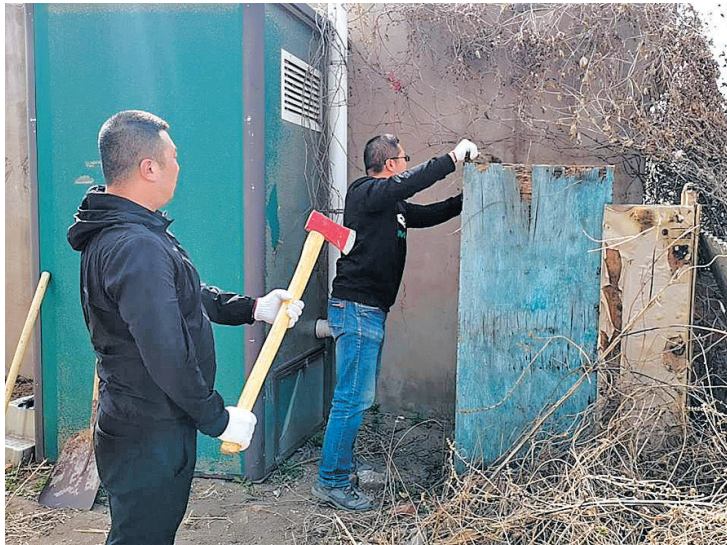
近日,铁西区北郊社区组织小区物业、学校、重点企业等单位开展旱厕排查整治专项活动。全力提升群众生活质量和人居环境,切实改善城区环境。 本报通讯员 侯小立 摄
