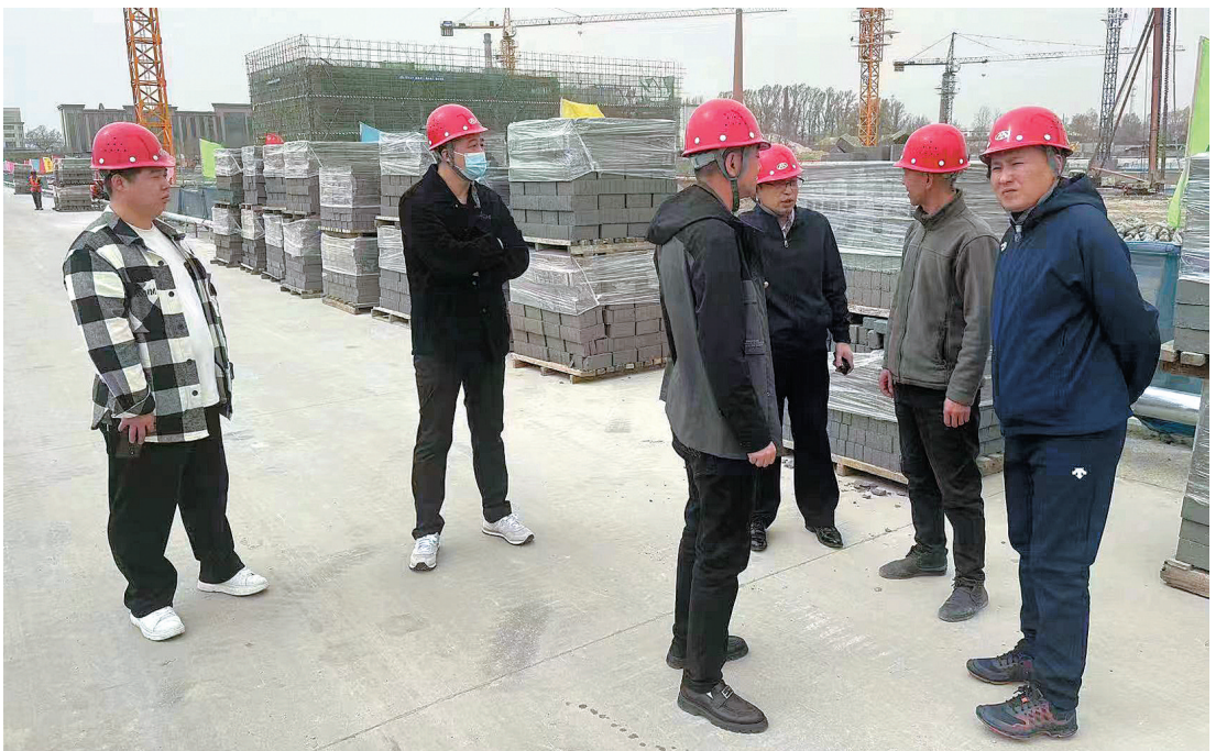
近日,伊通住建局为有效预防住建领域工伤事故发生,守牢安全生产底线,组织人员开展安全生产大检查工作。 本报通讯员 陈雷 摄
