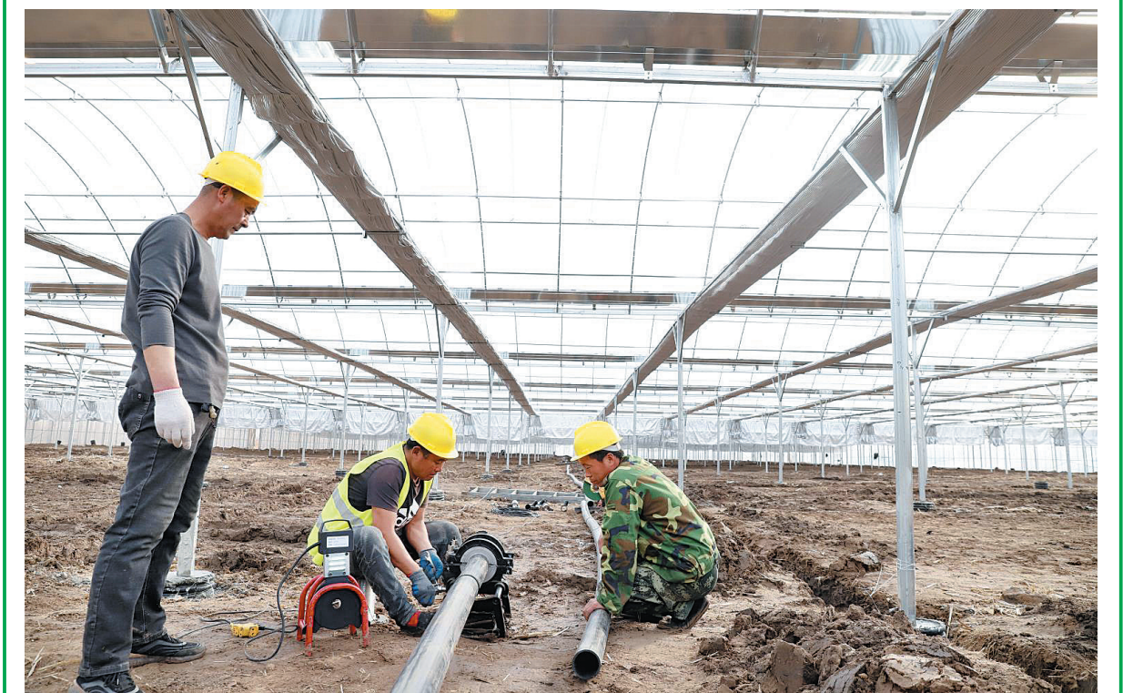
双辽市双山镇秀水村“水稻小镇”项目占地面积6000亩、计划投资2000万元，主体内容包括水稻育秧工厂、展厅、农旅、农田设施等，水稻育秧工厂主体框架建设已完成，相关配套设施预计也在近期完成并投入使用。
