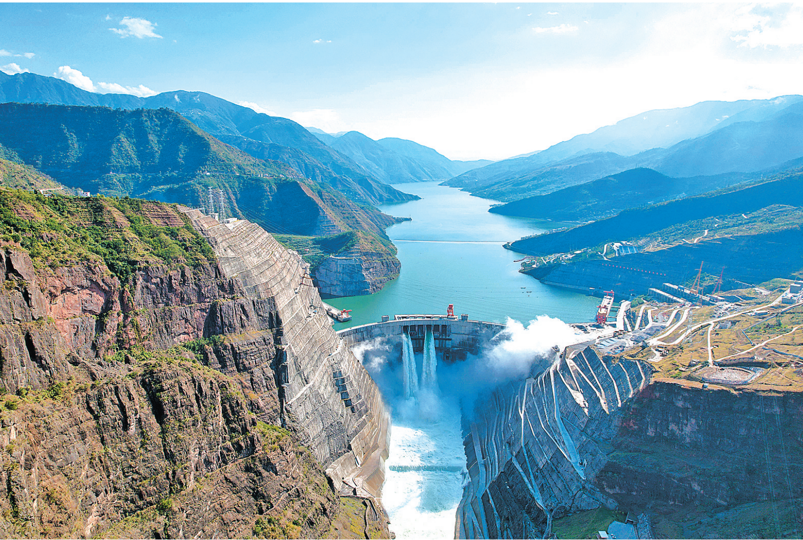
11月5日18时55分,白鹤滩水电站10号机组顺利通过72小时试运行,正式投入商业运行,这是白鹤滩水电站投产发电的第15台百万千瓦水轮发电机组,标志着白鹤滩水电站进入了全面投产发电的最后冲刺阶段。 白鹤滩水电站位于四川省宁南县和云南省巧家县交界的金沙江干流河段上,总装机容量1600万千瓦,是我国实施“西电东送”的国家重大工程,共安装16台我国自主研发的全球单机容量最大功率百万千瓦水轮发电机组。 新华社发(闫科任 摄)
