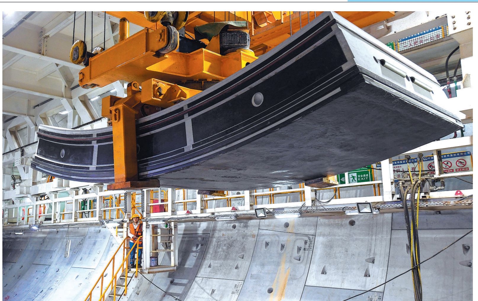
由中铁隧道局承建的深圳首条跨海隧道——妈湾通道海底盾构掘进已经完成1621米。妈湾跨海通道建成后将实现前海对外交通的“客货分离”,优化港区疏港交通组织。从空中到海底,前海基础设施和重点项目建设如火如荼。深圳前海合作区正在打造粤港澳大湾区全面深化改革创新试验平台,建设高水平对外开放门户枢纽。
