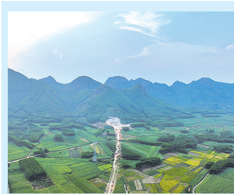
近日,由广西交通投资集团投资建设的新建柳州至广州铁路柳州至梧州段全线全面开工建设。该项目为国铁I级、双线电气化、客货共线铁路。拍摄的柳梧铁路1标段六绵山隧道项目。
