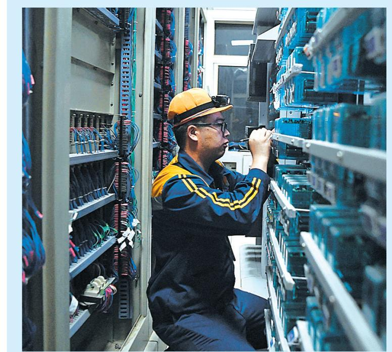
8月25日,由中铁八局电务公司和中国铁路兰州局集团嘉峪关电务段等单位负责施工的兰新铁路玉石站计算机联锁系统升级改造工作顺利完成。据了解,计算机联锁系统作为车站的控制中枢,被称为列车运行的“大脑”,集中控制车站的信号、道岔和轨道区段等信号设备,此次兰新铁路甘肃段共有玉石、高台、山丹等10座车站对“行车大脑”进行升级改造,预计9月15日前全部完工投用,将进一步提升兰新铁路客货运输效率。嘉峪关电务段信号工张源芝在兰新铁路玉石站作业。
