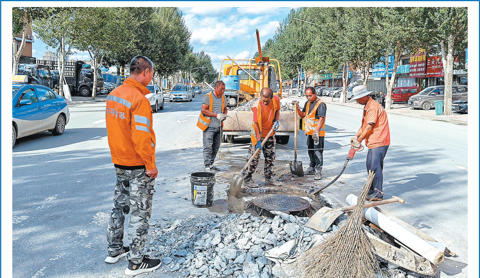
为保障市民出行安全,近日,市政维护管理处工作人员对市区内破损井盖进行更换,这是工作人员在铁东区一马路进行施工。
