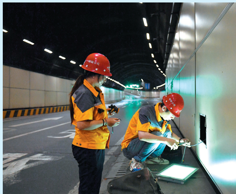
8月14日,位于湖南省长沙市的营盘路隧道是横穿湘江的第一条隧道,也是连接湘江两岸的过江主干道。检修工人利用每周末0时至6时的“空窗期”,对总长达8.5公里的隧道进行线路检修、坑洞修补等养护作业,保障市民顺畅出行。工人们在营盘路隧道检修。
