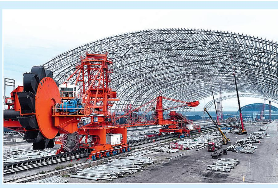
近日,河北省唐山港曹妃甸港区煤码头三期工程后续建设项目封闭式煤炭堆场条形储备仓建设正在稳步推进。据介绍,该储备仓设计能力93万吨,是曹妃甸港区推进煤尘抑制、减少污染的重要环保设施。工人在唐山港曹妃甸港区煤码头封闭式煤炭堆场条形储备仓建设工地施工(无人机照片)。
