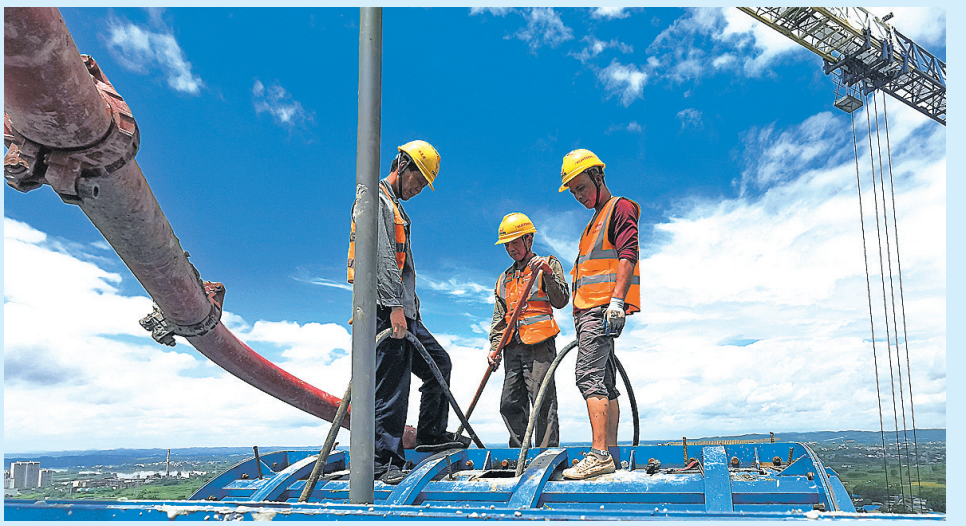
近日,由中铁十一局承建的南宁至玉林铁路六景郁江特大桥首座主塔顺利封顶。六景郁江特大桥全长11.465公里,主跨320米,本次顺利封顶的主塔总高度123米。南玉铁路设计时速350公里,是南深铁路的重要组成部分。工人在南玉铁路六景郁江特大桥首座主塔塔冠上进行封顶作业。
